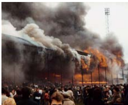
Während der Valley-Parade-Katastrophe starben 56 Menschen. Viele von ihnen konnten nicht fliehen, weil die Notausgänge verriegelt wurden, um unerlaubte Zutritte zum Stadion zu verhindern.
